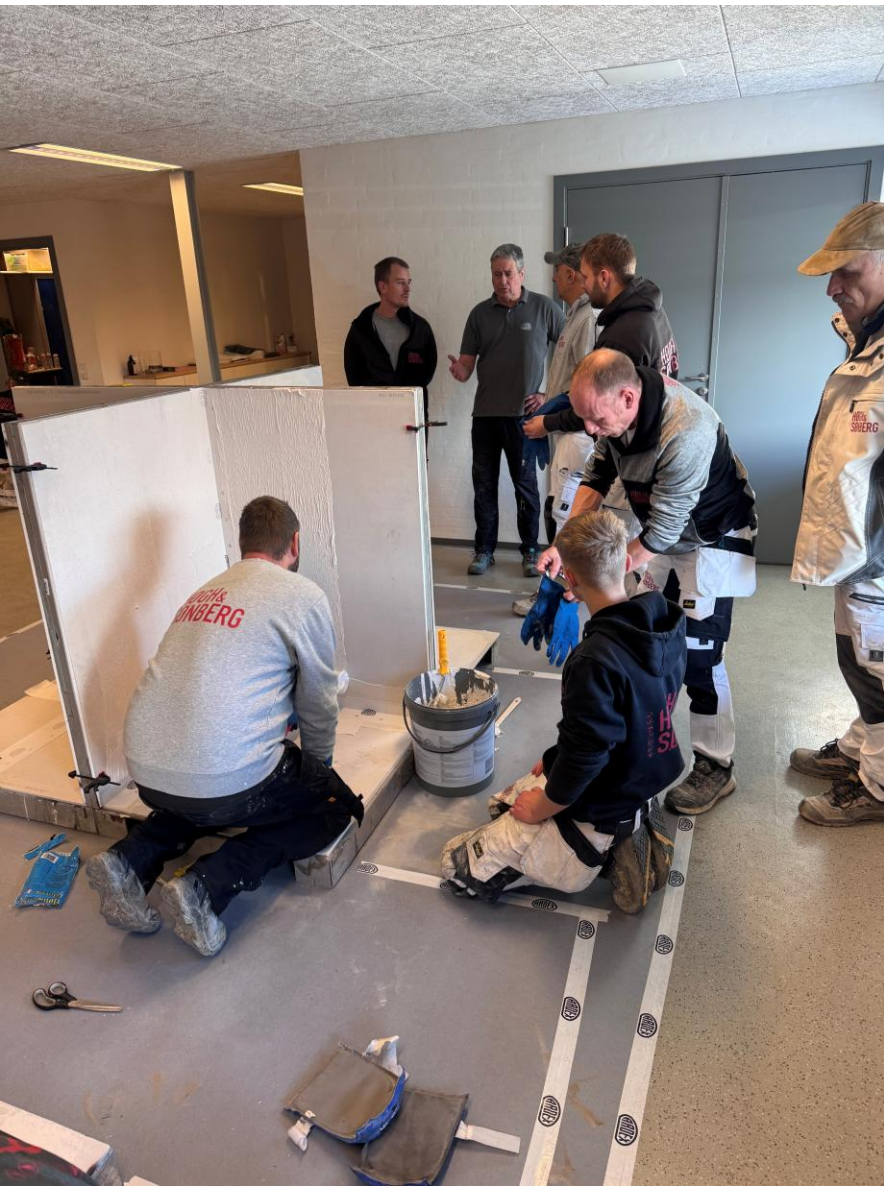
Vores murere på vådrumsworkshop ved ARDEX i december 2025
